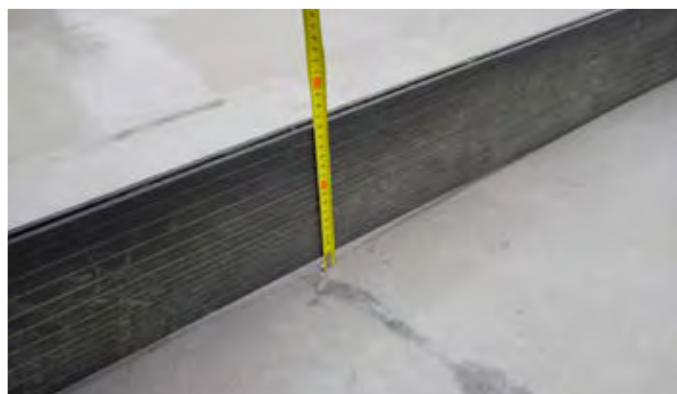
Obr. 3 Trvalý priehyb degradovanej OSB dosky hr. 15 mm bol nameraný max cca 20 mm. Vďaka tomu bolo zrejme, kde sú stropnice a znížilo sa riziko prepadnutia počas pohybu po streche.
