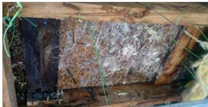
Obr. 2 Pohľad na OSB dosku záklopu kompletne pokrytú hubami a znateľne mokrú stužujúcu fošňu.
