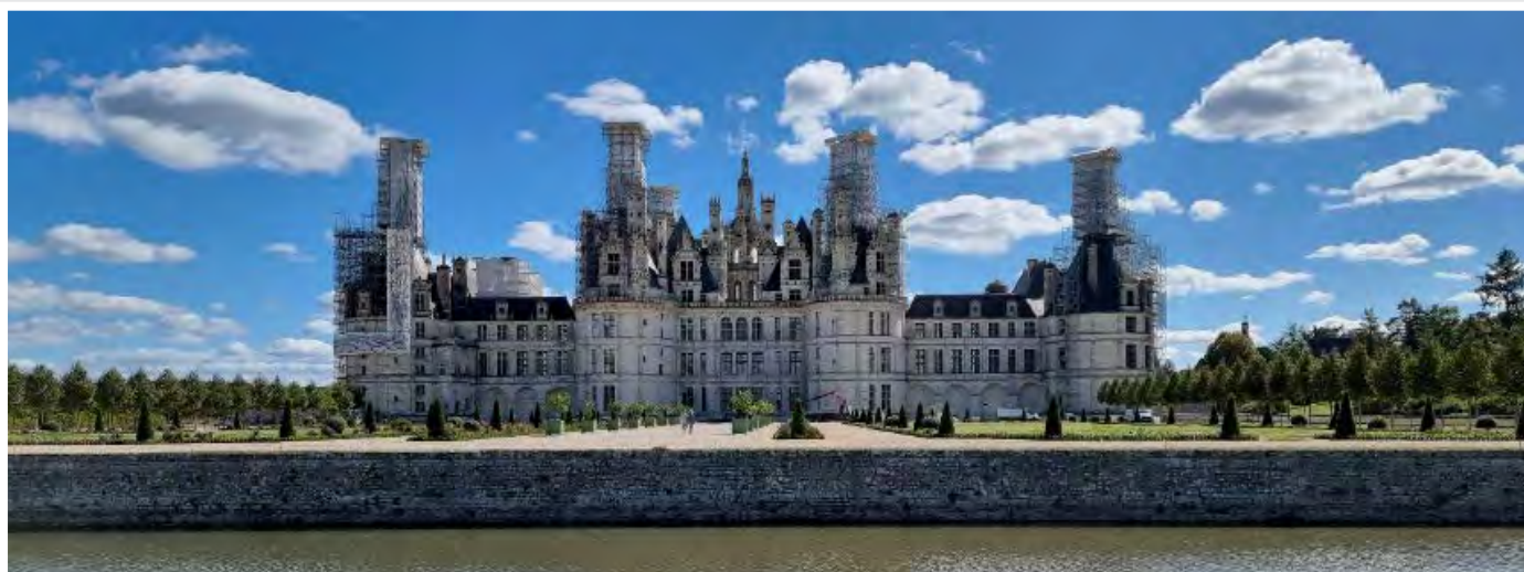
Obr. č. 1 – Celkový pohled na zámek Chambord, včetně opravovaných věží
