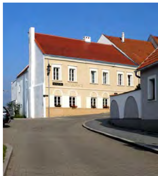
Systém Nebesys v instalaci na hotelu Duo v Mikulově - pohled z ulice
