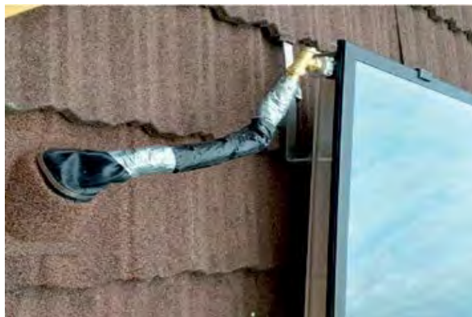
Obr. Bezpečný prestup káblov cez krytinu s originálnym dielom Metrotile mTnŠk-AP
