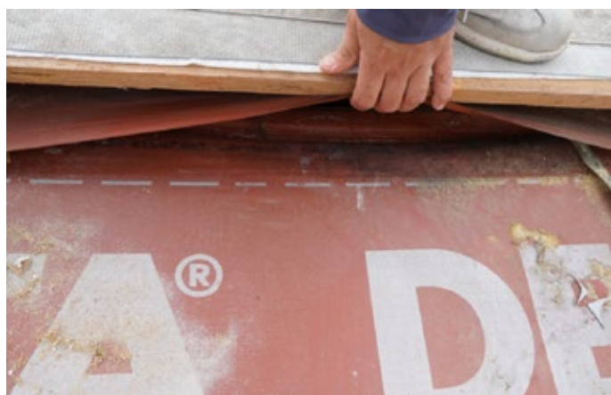
Obr. 1 Ukážka vetrotesného spoja v praxi vďaka integrovanému samolepiacemu okraju poistnej hydroizolácie
