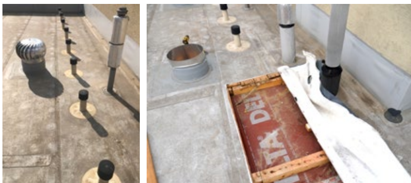
Obr. 5 Dodatočne realizované vetracie komínky pre prívod vzduchu do vzduchovej medzery
