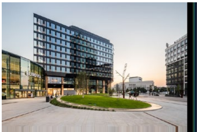
V mieste medzi sklenenou kupolou a budovami bola fólia DELTA®-FLORAXX TOP použitá pod ozelenením, pochôdznou plochou a štrkom zaťaženou plochou.
