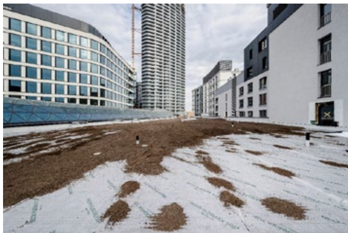
Fólia DELTA®-FLORAXX TOP bola aplikovaná v skladbe zelenej strechy medzi budovami ako drenážna a hydroakumulačná vrstva. Na obrázku je položená fólia s čiastočným prekrytím alebo zaťažením v mieste presahu.
