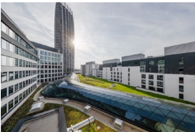
Presklená strecha, ktorej tvar je inšpirovaný Dunajom, vedie medzi administratívnou budovou PRIBINOVA 34 a rezidenciami RIVERSIDE a spája existujúcu a novú budovu obchodnej pasáže.
