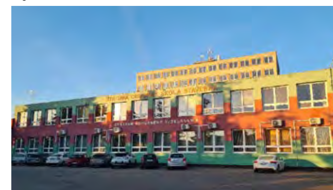
Budova školy: SOŠ stavebná – ĚSzkI, Nitrianska cesta 61, Nové Zámky
