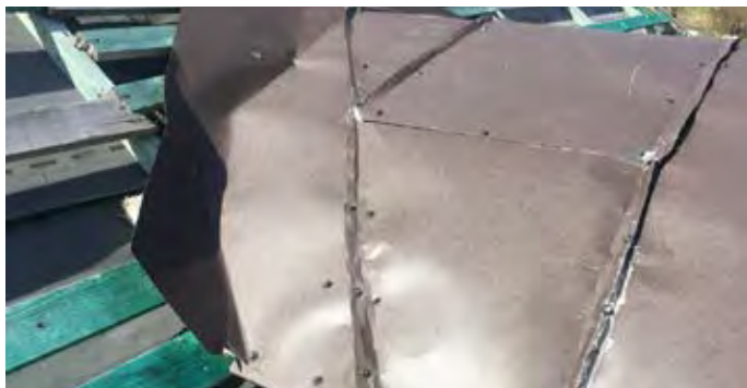
Obr. č. 3 - Pohľad na oplechovanie oblúkového vikiera pomocou farmárskych skrutiek.
