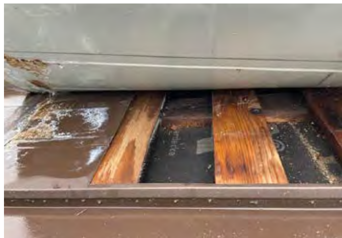
Obr. č. 17 - Ukážka dôsledkov nesprávneho vyhotovenia priečných spojov v závislosti od strešného sklonu, „klik“ systém.
