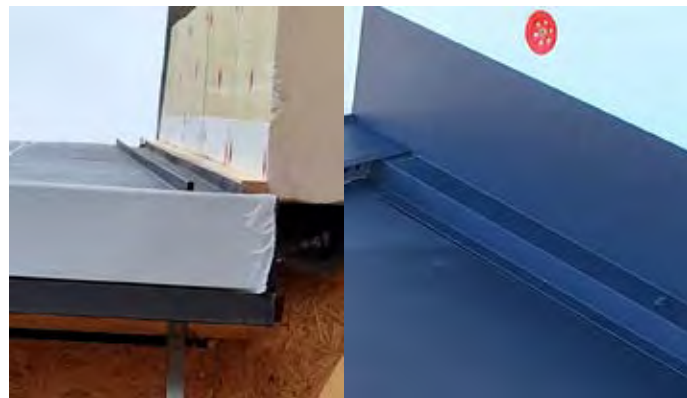
Obr. č. 6 a č. 7 - Pohľad na oplechovanie bočného lemovania pri stene systém „KLIK“, RD Kopčany.
