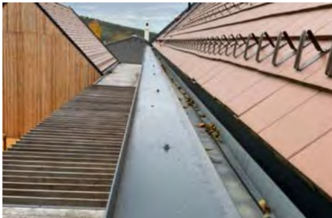
Obr. č. 2 - Pohľad na oplechovanie atiky zaatikového žľabu pomocou farmárskych skrutiek.
