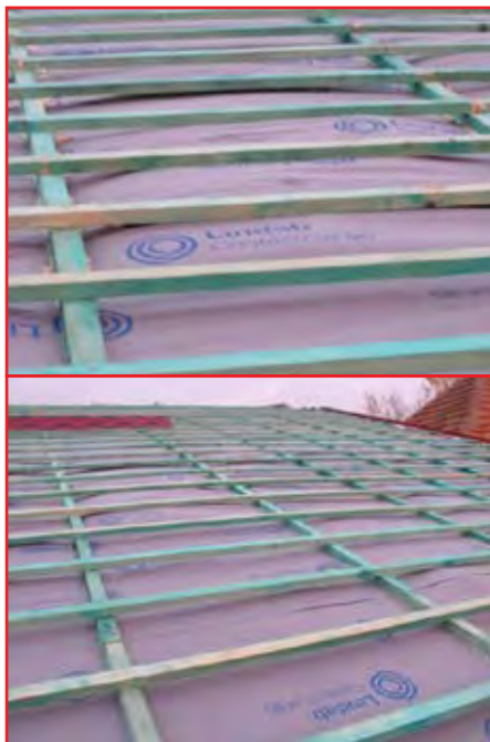
b) Vyduť DHV (podstřešní membrány) vlivem stříkané PUR pěny
