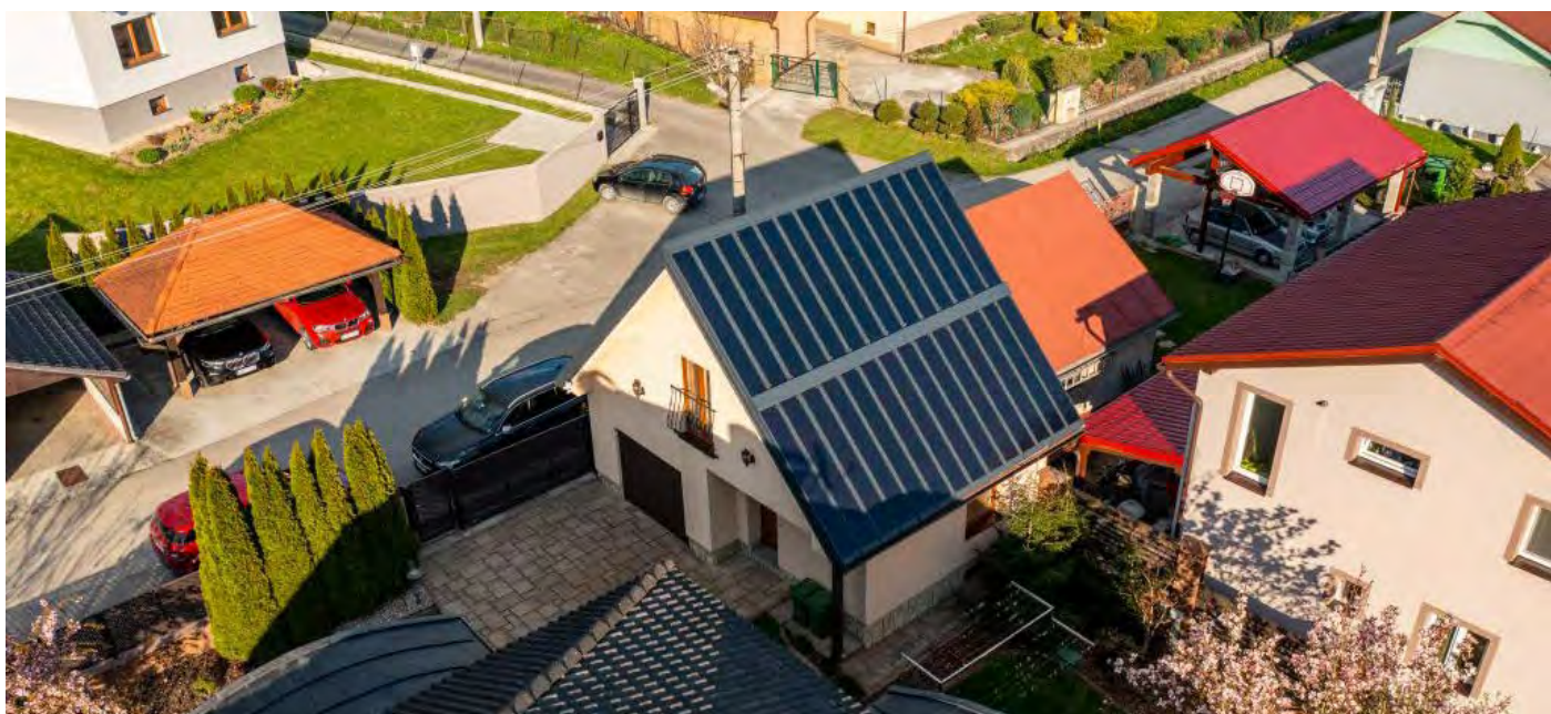
Realizácia fotovoltaickej strešnej krytiny ARTROOF od firmy ARTCO, s.r.o., Žilina
