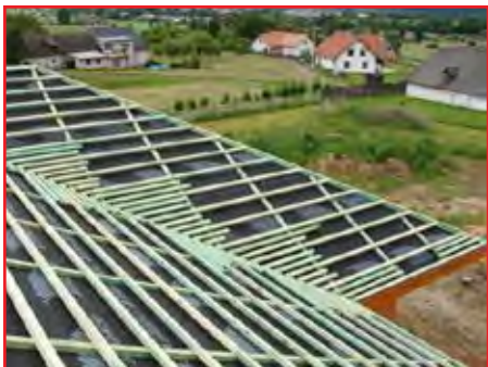
a) Vyduť DHV (podstřešní membrány) vlivem foukané izolace
