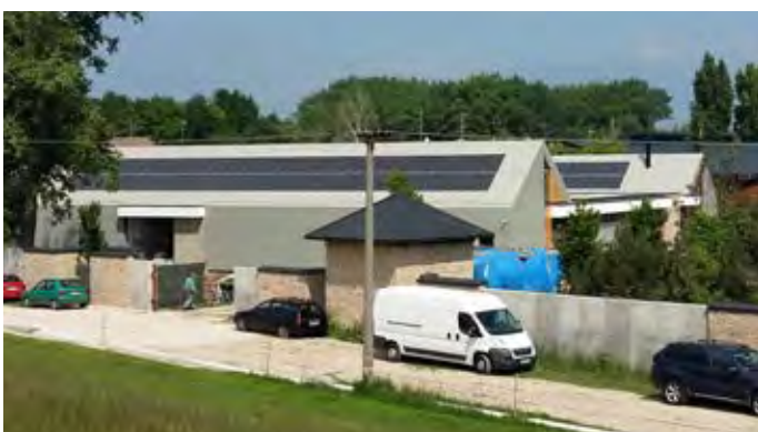
Pohľad na zastrešenie a opláštenie RD-u, Nová Stráž (systém: SWISSPEARL)
