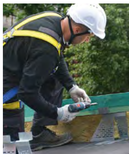
Obr. 7 - 9 Zateplení šikmé střechy nad krokviemi pomocí izolací z kamenné vlny ROCKWOOL – systém TOPROCK
