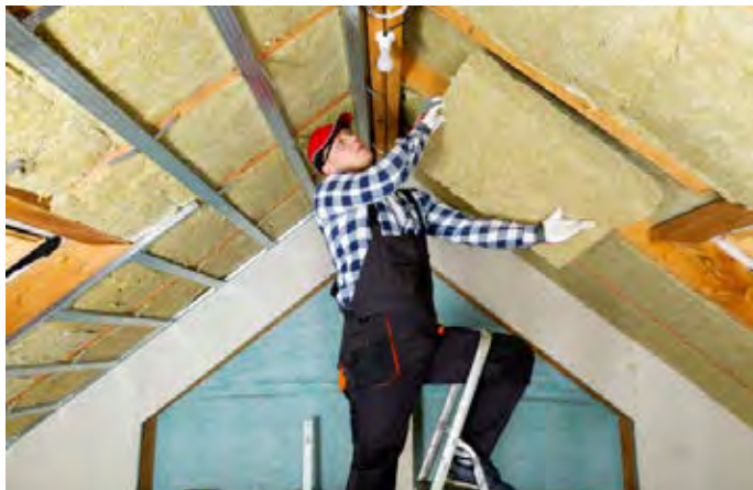
Obr. 1 Zateplení šikmé střechy nehořlavou izolací z kamenné vlny ROCKWOOL
