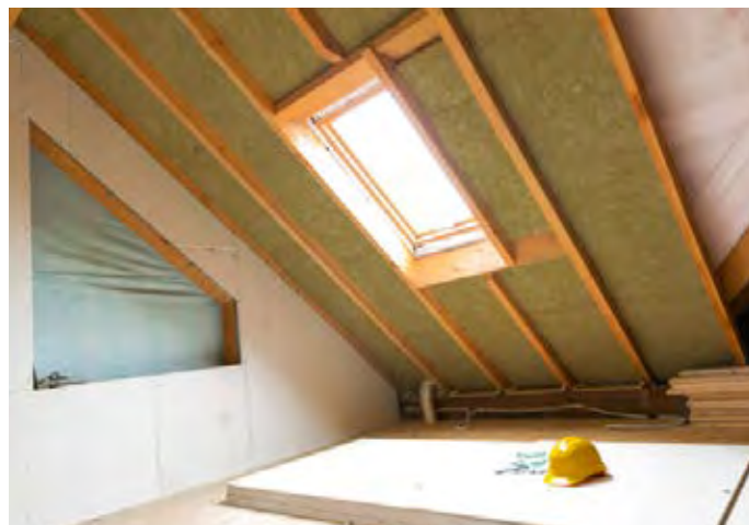
Obr. 2 Šikmá střecha zateplena vložením izolace mezi a pod krokve
