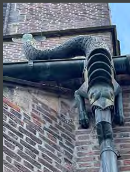
Střešný kotlík - detail
