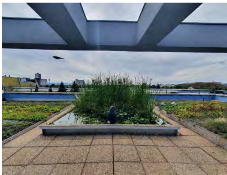
Mokradľová strecha na budove firmy IZOLA Košice, s.r.o.
