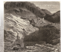
Čelivý pohľad na Šifrovú jamu v Marianke. Vľavo sa nachádza Ťažobná jamy a pravo štítny stôp. Pravo v ústí do bridlicovej štítny. Iné: Šifrová jama v Marianke. Vrchol štítny s bridlicou. Mera bola vyfúkaná na povrch v debách dopravovaných na lanoch. V pravo: hradba. Čech je drevná konštrukcia na prelievanie bridlice z debny na voľný povrch na koľnicových do podielu. Zdroj: Ludwiger Illustrirte Blätter, Nr. 51, 1864.
