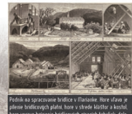
Pohľad na spracovanie bridlice v Marianke. Vľavo je písacie bridlicové pláty, hore v strede kufčina a kufčina hore vpravo hromadná mechanizovaná výroba pálených škrudie. Škrudie bridlicové písacie tabuľky boli postupne nahradzované papierovými zošími. Ťažba bridlice obmedzil aj začiatok 1. svetovej vojny a v roku 1916 bola ťažba bridlice v Marianke definitívne ukončená. Zdroj: Ludwiger Illustrirte Blätter, Nr. 51, 1864.
