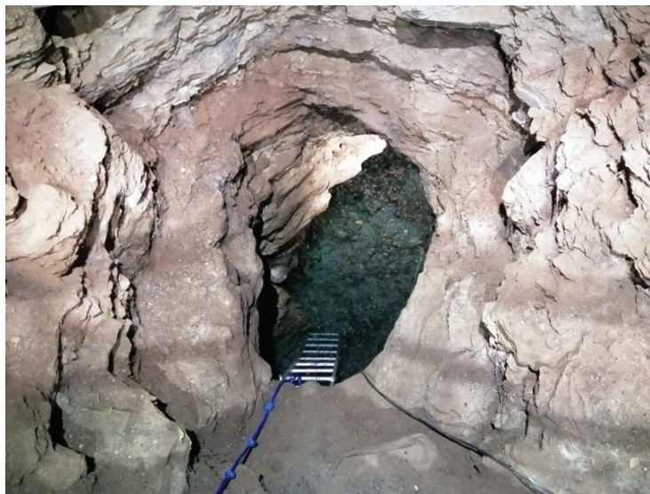
Zatopené ústie bridlicovej štôlne s bezpečnostným rebrikom (foto: Roman Lehotský)
